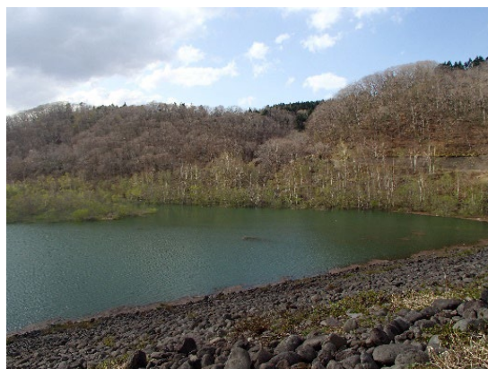
ダム湖環境創出箇所
