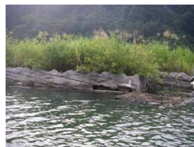
浮島の直立外壁の状況
